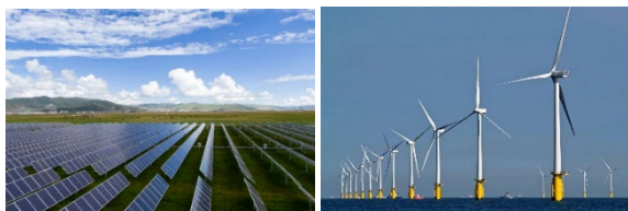
光伏 solar power
