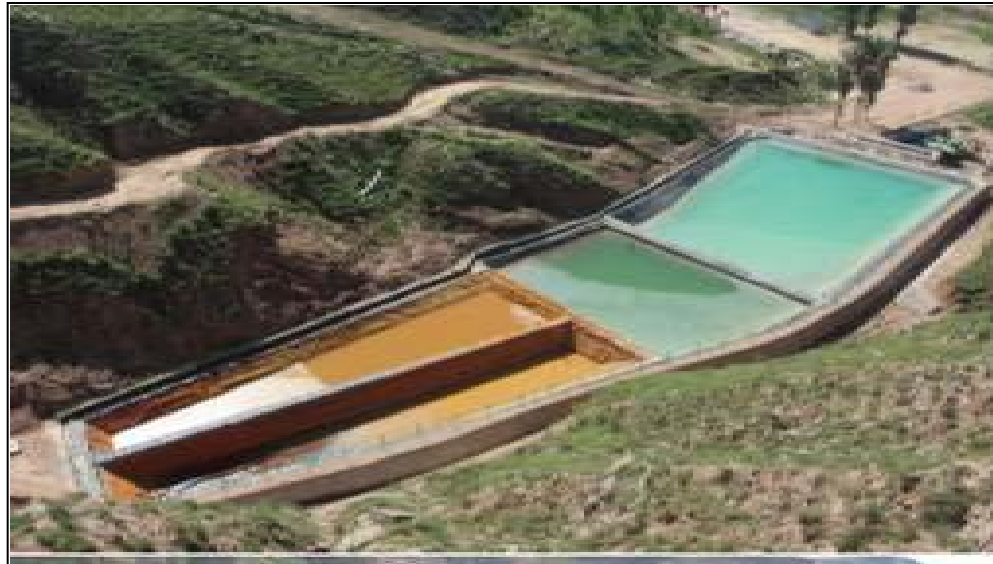
Water treatment station 水处理站
