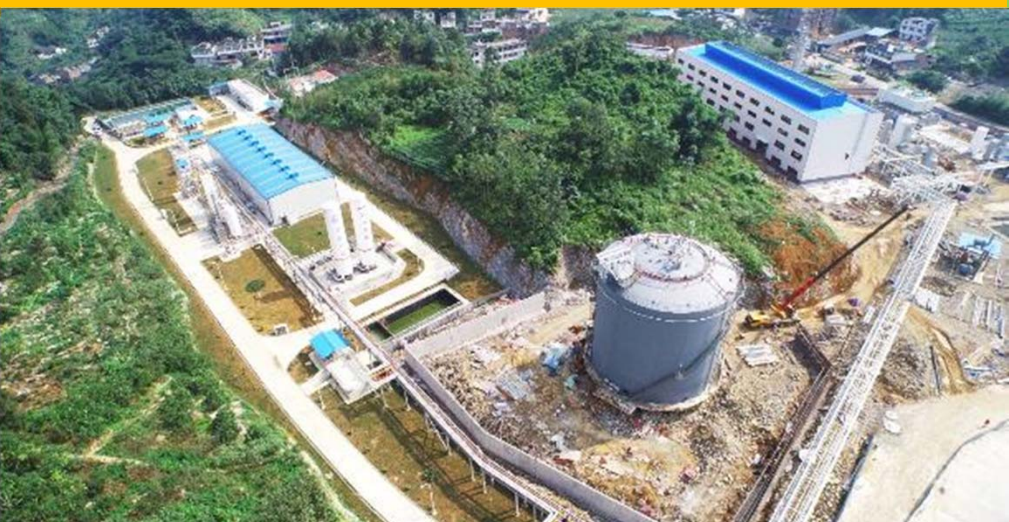
杰瑞在固定液化化工厂方面，已经承建了国内多个液化化工厂项目
