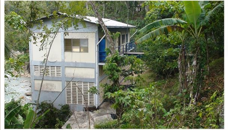
Centrale Hydro électrique de Saut-Mathurine (Cayes - Camp-Perrin))
