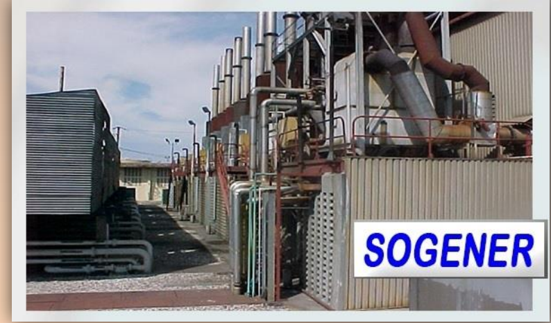
Centrale Thermique de Varreux 1 (Port-au-Prince - Cité-Soleil - Varreux)
