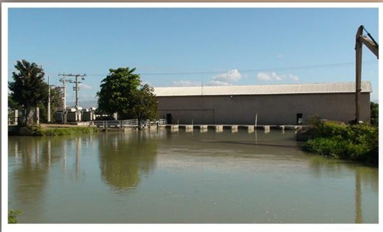
Centrale Hydro électrique de Drouet (l'Estère - Pont-Sondé)
