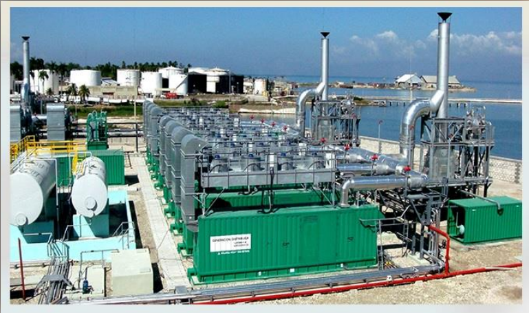
Centrale Thermique Alexandre Pétion (PBM - Carrefour 2)
