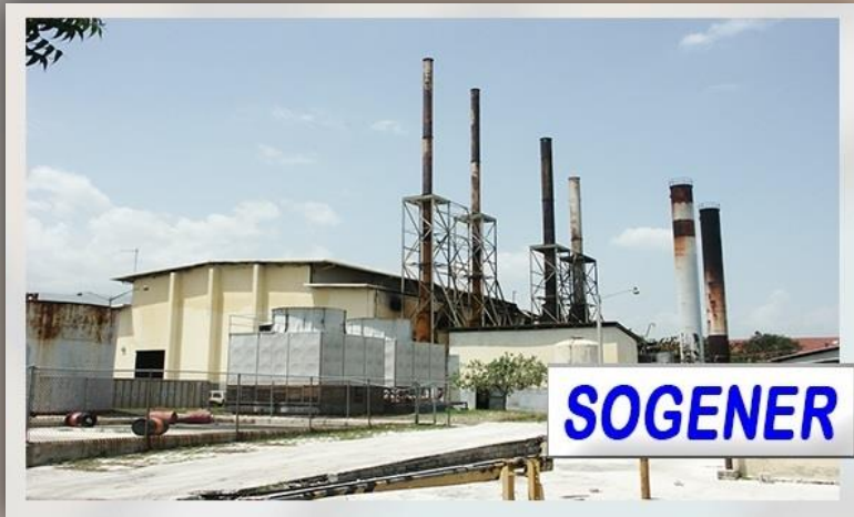
Centrale Thermique de Varreux 1 (Port-au-Prince - Cité-Soleil - Varreux)
