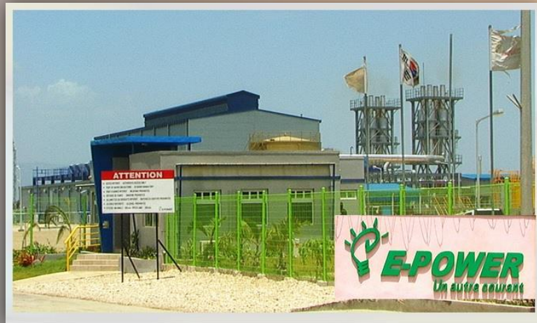
Centrale Thermique E-Power (Cité-Soleil - Sarthe)
