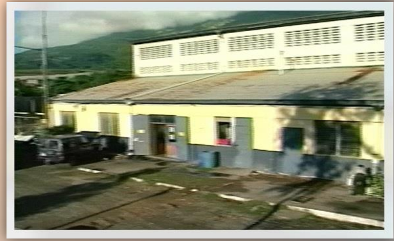
Centrale Thermique de Ste-Philomène (Cap-Haïtien - Vaudreuil)
