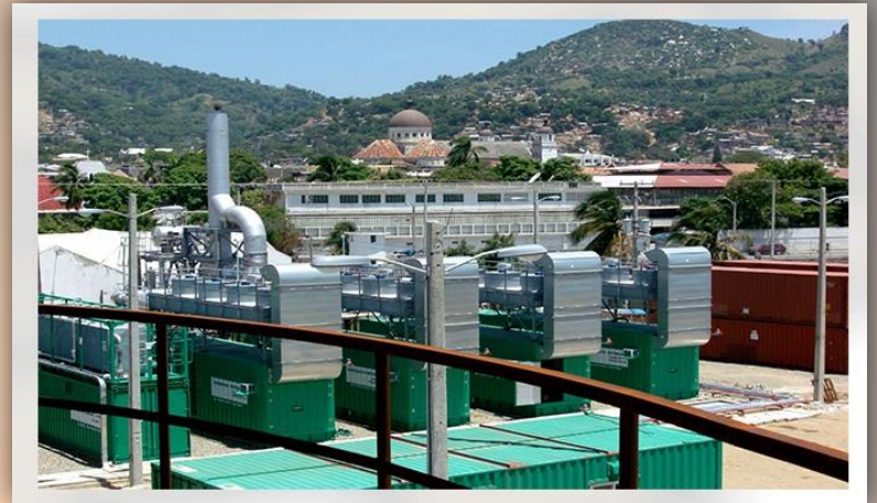
Centrale Thermique de Jose Marti (PBM - Cap-Haïtien)
