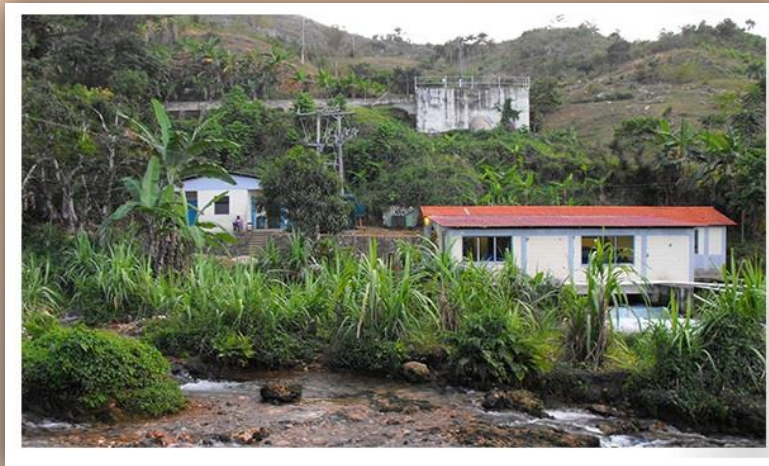
Centrale Hydro électrique de Onde-Verte (Belladère - Ti Priz)
