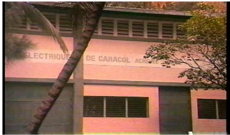
Centrale Hydro électrique de Caracol (Trou du Nord - Caracol)
