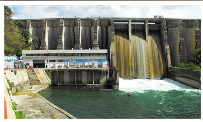
Centrale Hydro électrique de Péligre (Mirebalais - Dlo Gaye)
