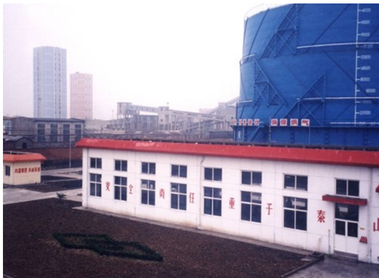
民用瓦斯气站 gas station
