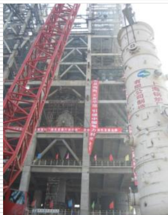
2010年10月气 化炉安装 Gasifier was installed in October, 2010.
