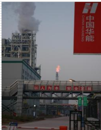
2012年4月17日气 化装置首次投料 First feeding of gasification devices in 17th, April, 2012
