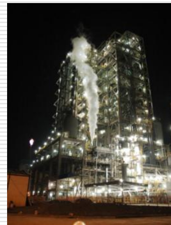
2012年11月6日， 中国首个IGCC工程 进入商业运行 First IGCC project in China was put into industrial operation in 6th, November, 2012
