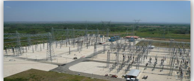
Subestación Bolívar 500 / 220 kV - ISA
