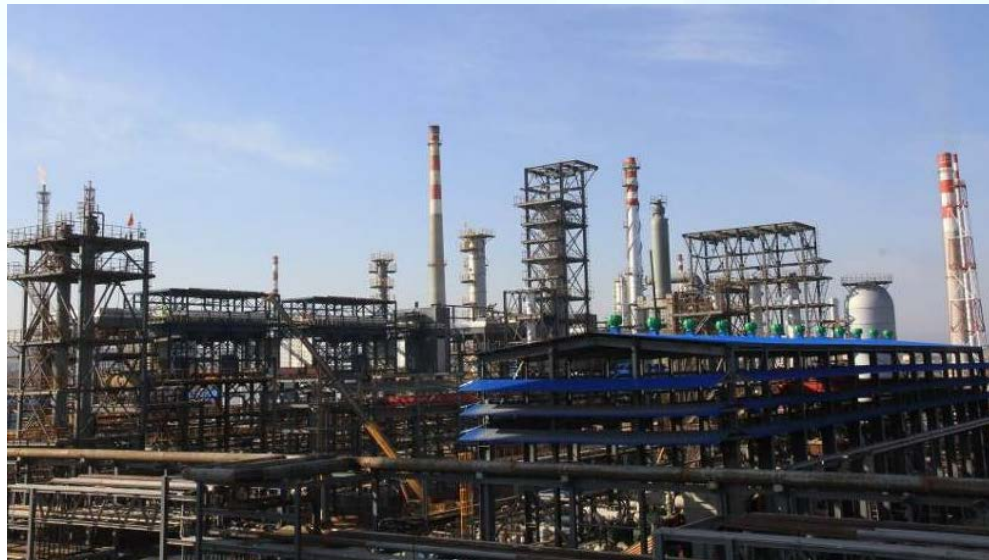
油煤共炼示范项目
