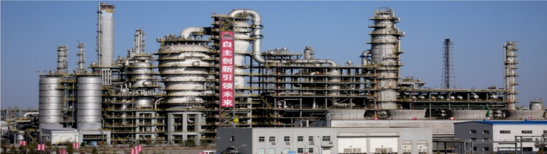
世界首套60万吨/年煤制烯烃工业化装置
