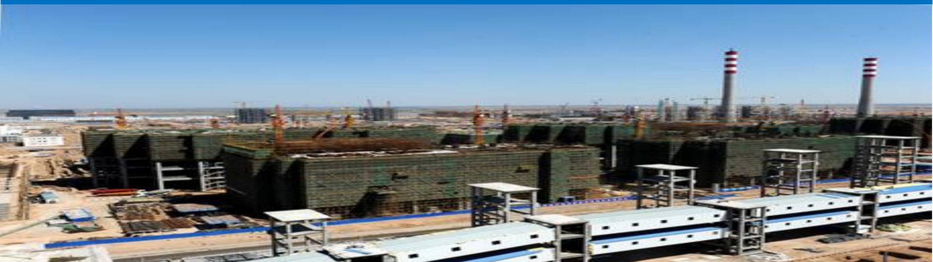
400万吨煤间接液化（在建）
