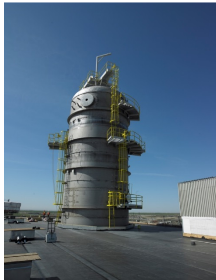
再生塔 CO 2 Stripper
