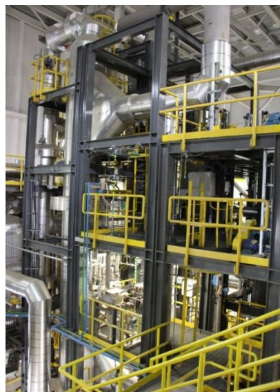
硫酸分部 Acid Plant
