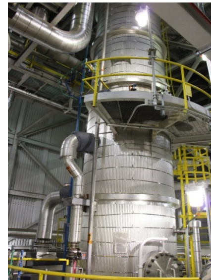
硫再生塔 SO 2 Stripper
